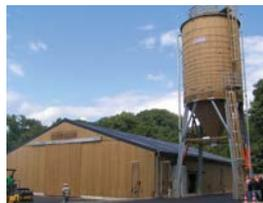
Le **métal** est couramment employé dans les structures de stockage de fondants routiers, à condition de prévoir une **protection adaptée** contre la corrosion.
