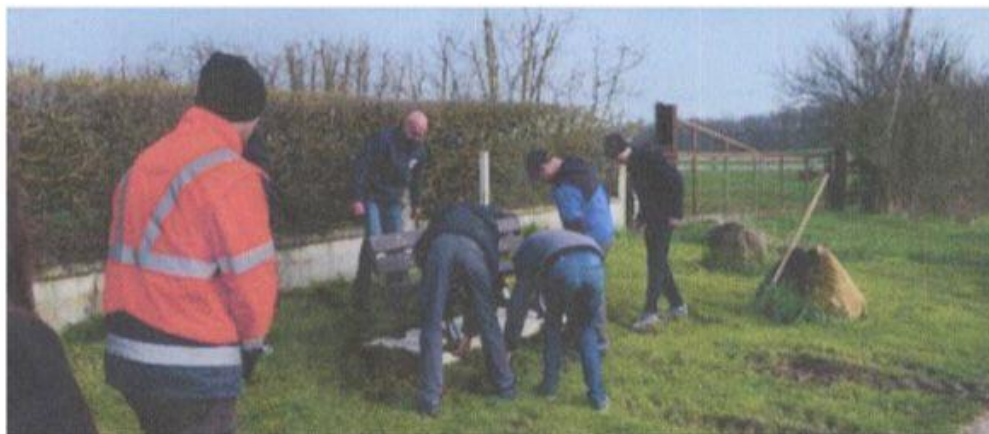
En pleine installation des bancs aux abords du bois de Tilly.
