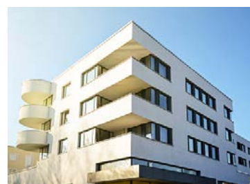
Immeuble collectif plus dense (dont le gabarit est au moins égal à 75 % du gabarit maximal autorisé par le PLU, le taux est de 85 % si au moins 50 % des logements sont sociaux ou intermédiaires). Immeuble livré le 7 juillet 2025.
