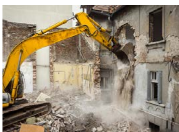
Démolition de l'immeuble par l'acquéreur. Vente doit intervenir avant le 1 er janvier 2024.
