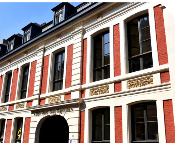
Reconversion de l'ancien hôpital Saint-Jean-Baptiste, Aire-sur-la-Lys (62).
